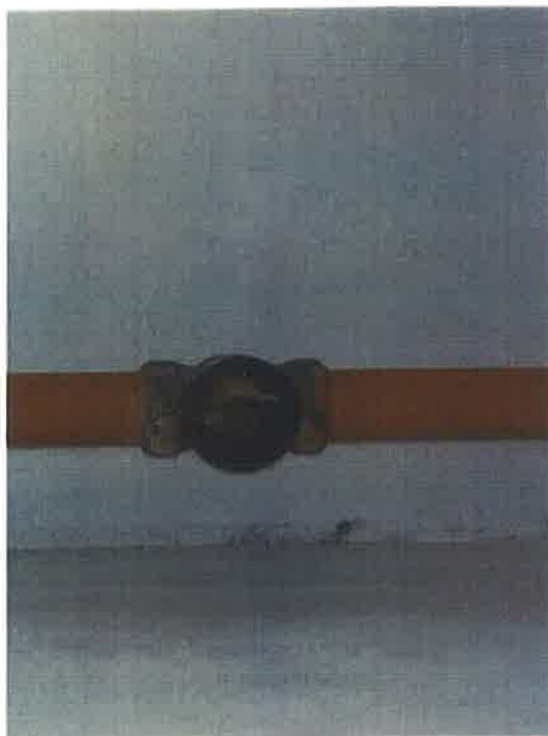
1185/1. NP – doplnit bezpečnostní tabulky „Hlavní uzávěr plynu“ + na vstupní dveře do prostoru
